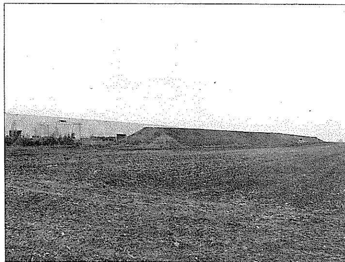
Un merlon de six mètres de haut vient d'être aménagé pour amortir les bruits générés par l'activité de la GTM.
